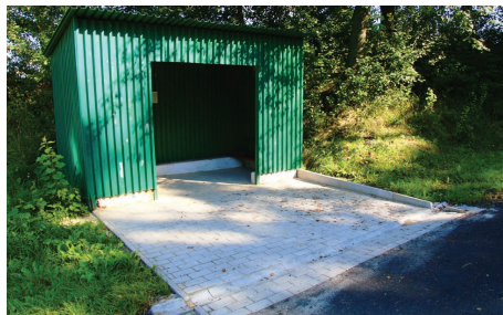
Vydláždění stání s odvodněním v autobusové čekárně v Březí.
