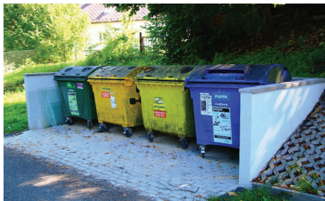
Stání pro kontejnery na tříděný odpad v Březí.
