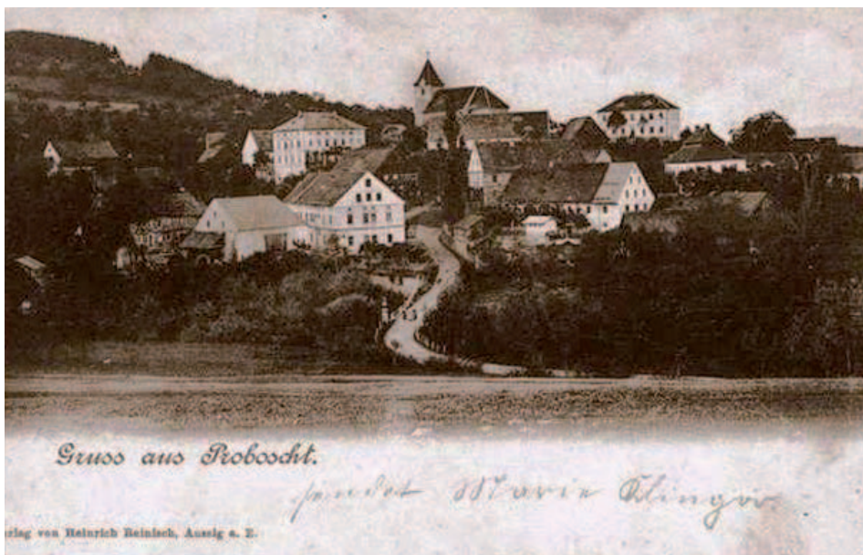
Historická pohlednice Proboštova.
