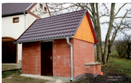
Stavba nové vodárny.
