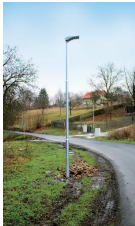
Rekonstrukce a rozšíření veřejného osvětlení v Proboštově.
