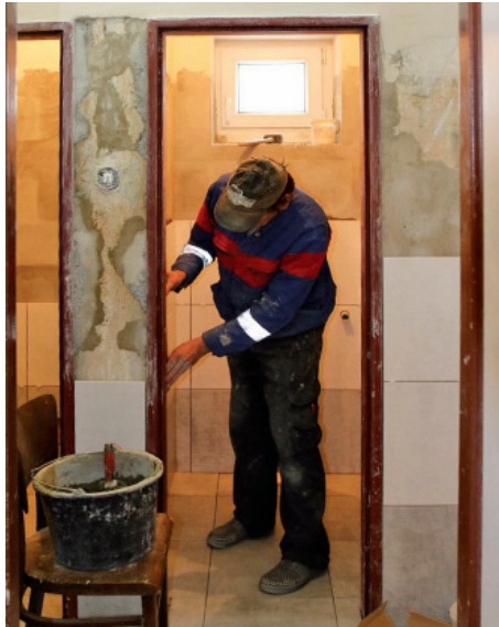
Oprava toalet v KD Malečov.
