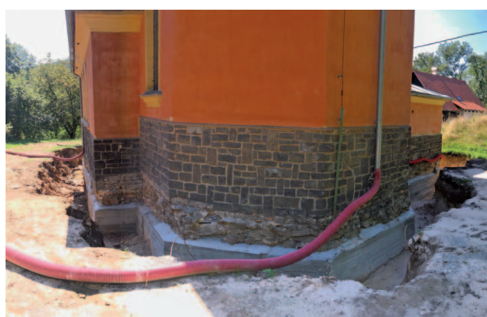
Dva snímky s pohledem na odkryté základy kostela, které byly po částech podbetonovány.
