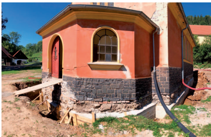
Dva snímky s pohledem na odkryté základy kostela, které byly po částech podbetonovány.
